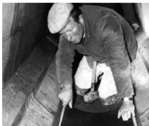
Pokládání kameninových plátků do speciální pokládací malty PCI Kanalit, odolné proti sulfátům, v betonovém žlabu kanálu.
