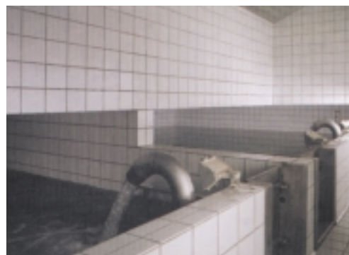
Spolehlivá izolace zásobníků pitné vody štěrskem PCI-Dichtschlämme.
