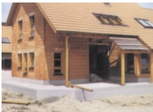
Mrazuvzdorná izolace železobetonu s PCI-Dichtschlämme v nesoudržné půdě.
