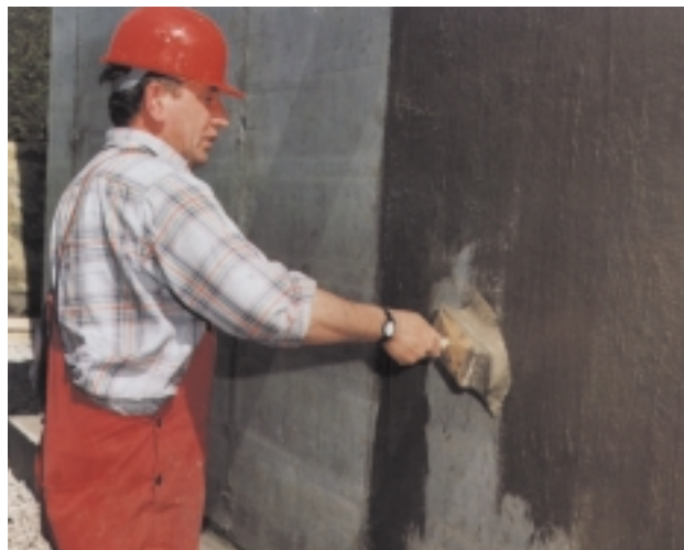
PCI-Dichtschlämme je plastická izolace na bázi cementu, póry a prohlubně jsou proto snadno a rychle uzavřeny.
