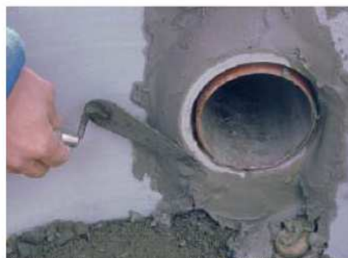
Sachtový vtok opravený s maltou PCI Polyfix plus
